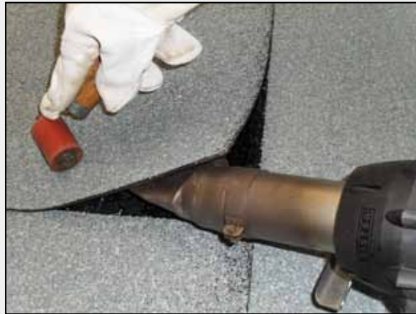
Sicherer Nahtverschluss und optische Kontrolle durch ausgetretene Bitumenraupe.
