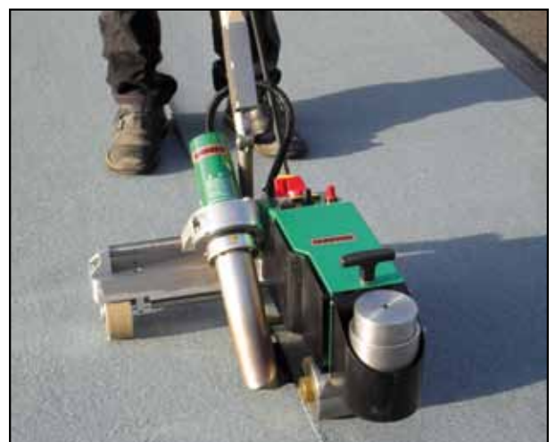
Sicheres Nahtverschweißen mit dem Heißluftautomaten.
