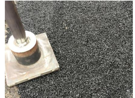
**Corabit REP** ist ein Reparaturasphalt und eignet sich zum Ausbessern von Frostausrissen und Schlaglöchern, zum Beseitigen von Schäden auf Asphaltdecken, zum Behandeln von Einbaunähten und zum Nacharbeiten von Fertigeriefen.
